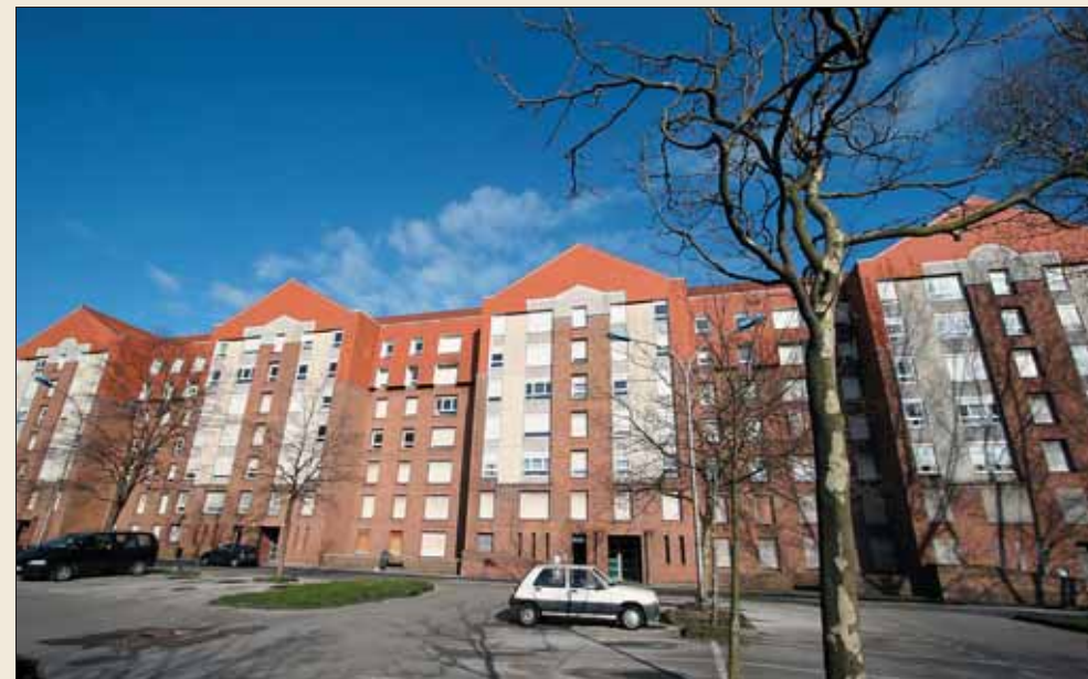
Au Banc Vert, les résidences Quercy et Rouergue seront démolies d'ici la fin de l'année.
