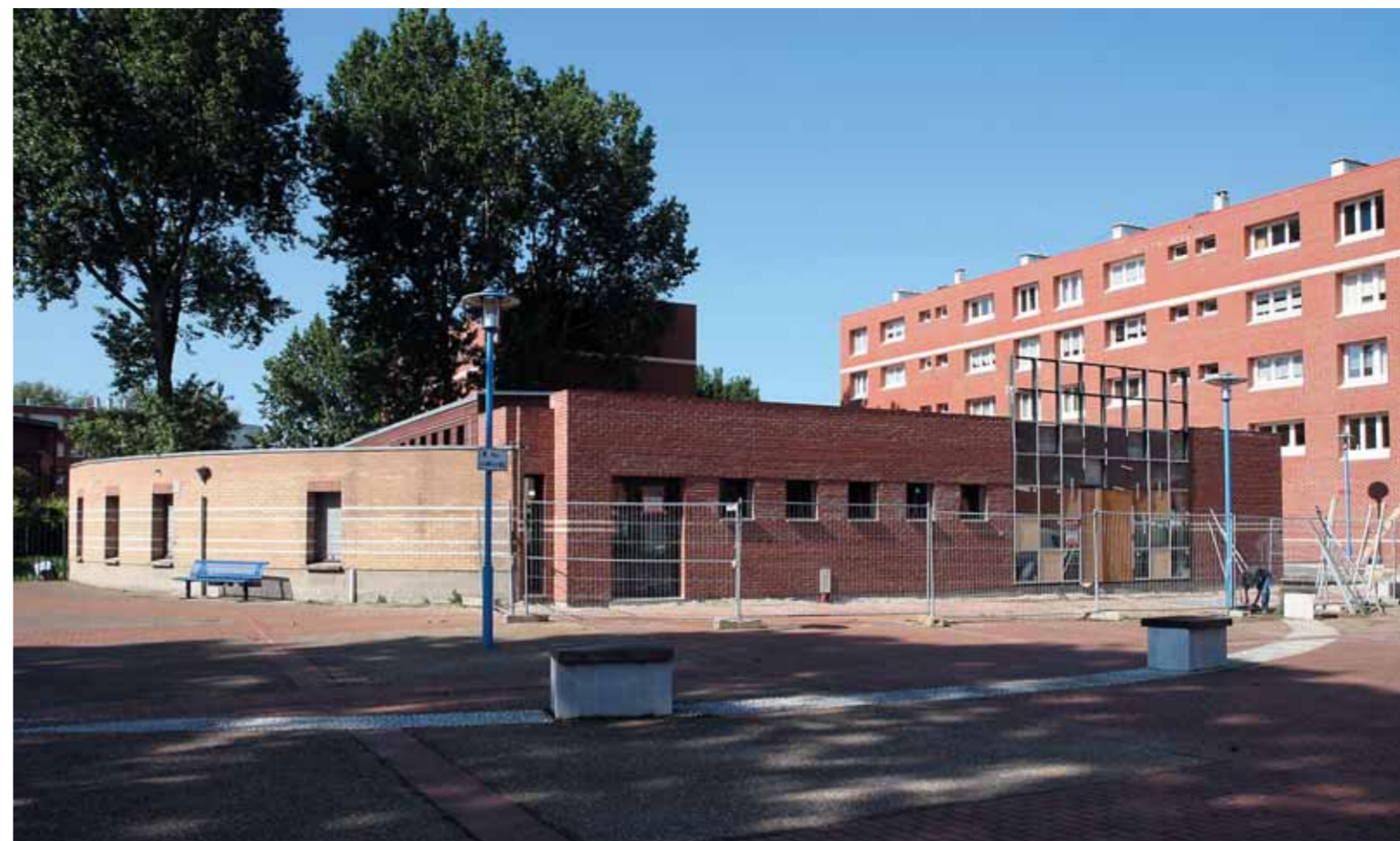
Débuté en janvier, le chantier de rénovation de la maison de quartier s'achève.
