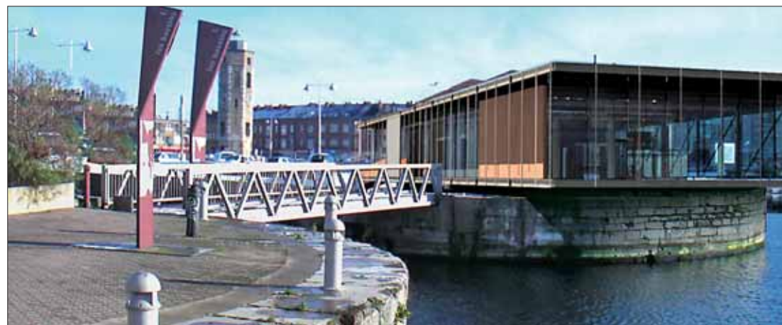
Le futur restaurant « Le Corsaire », dont la salle surplombera le bassin du Commerce.
