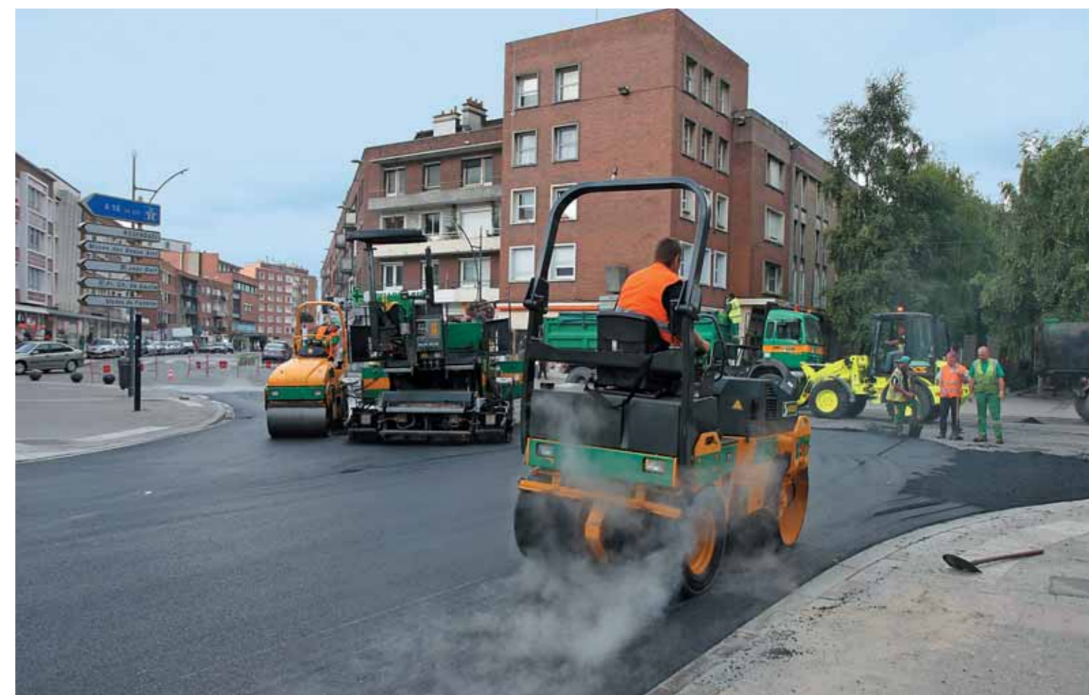
Un enrobé scintillant a été posé sur le pourtour de la place Jean Bart.
