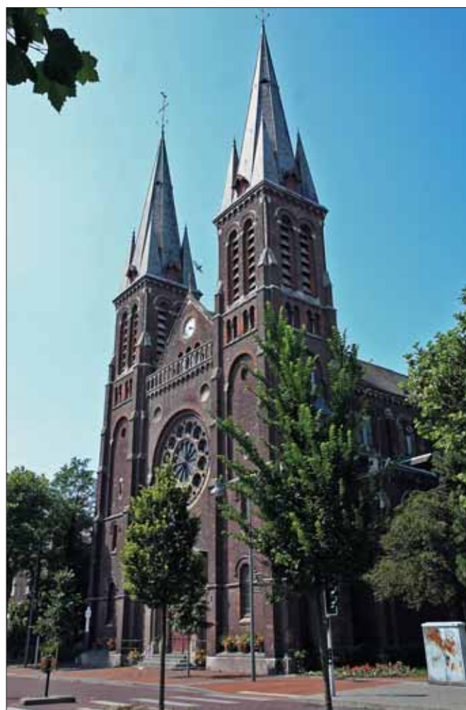
La rénovation de la façade de l'église Saint-Martin débute ce mois-ci.
