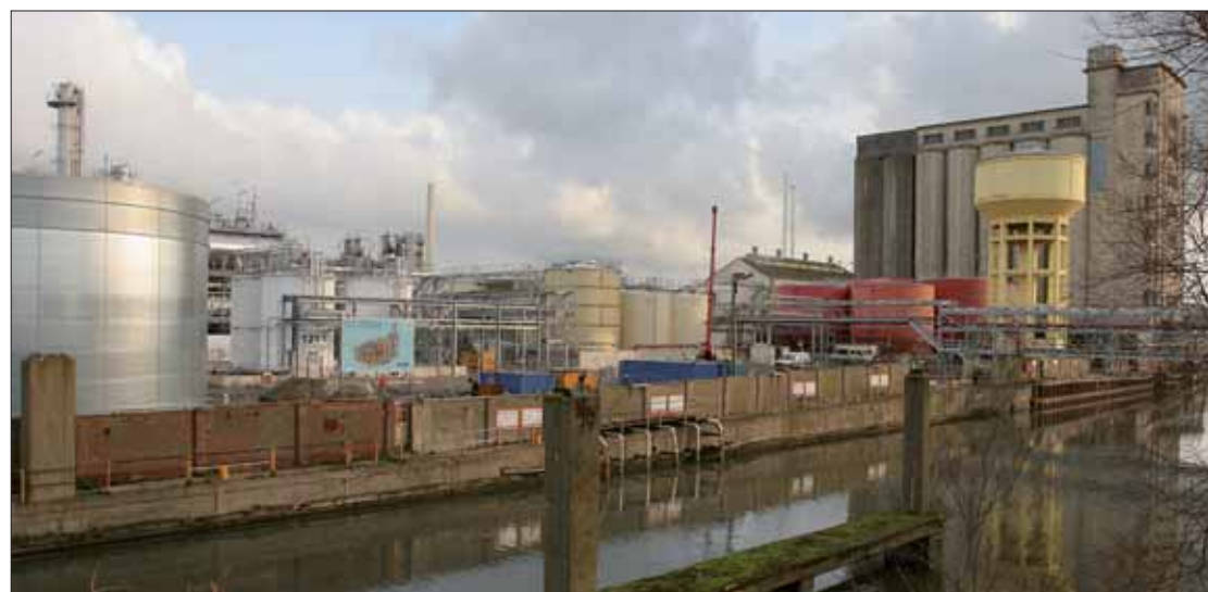
Diester Industrie a investi près de 40 millions d'euros dans la construction de son usine.
