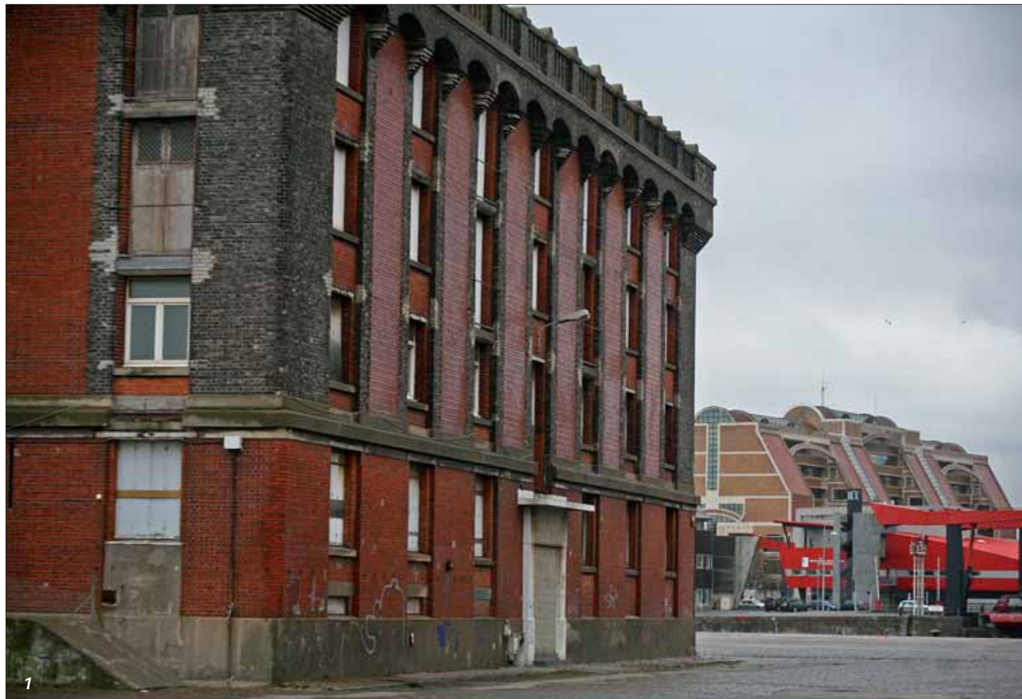
1- L'entrepôt réel des sucres est représentatif de l'architecture de stockage de la fin du XIX e siècle.
