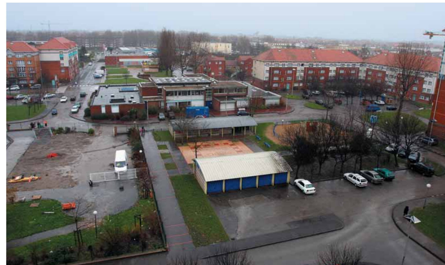
Derrière la maison de quartier, l'espace central accueillera un nouveau square.
