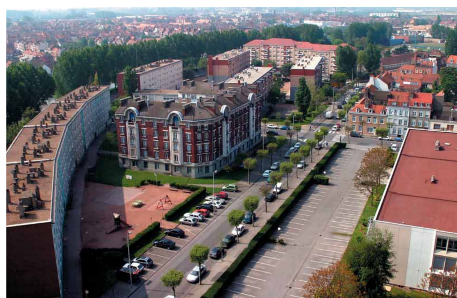
Un premier projet portera sur l'aire de jeu du bâtiment V.
