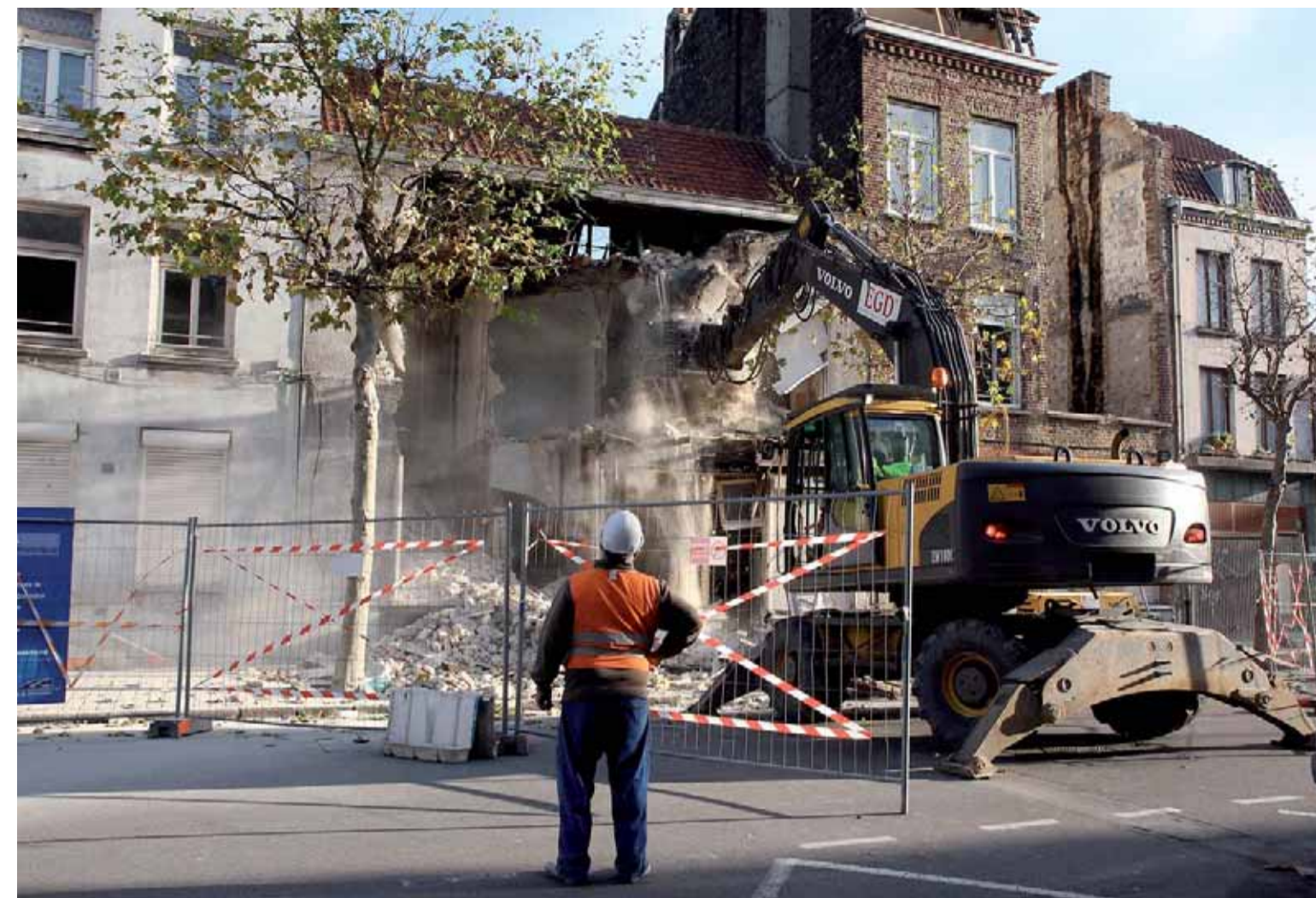
C'est un pan entier de l'îlot Saint-Mathieu qui est entré en travaux.
