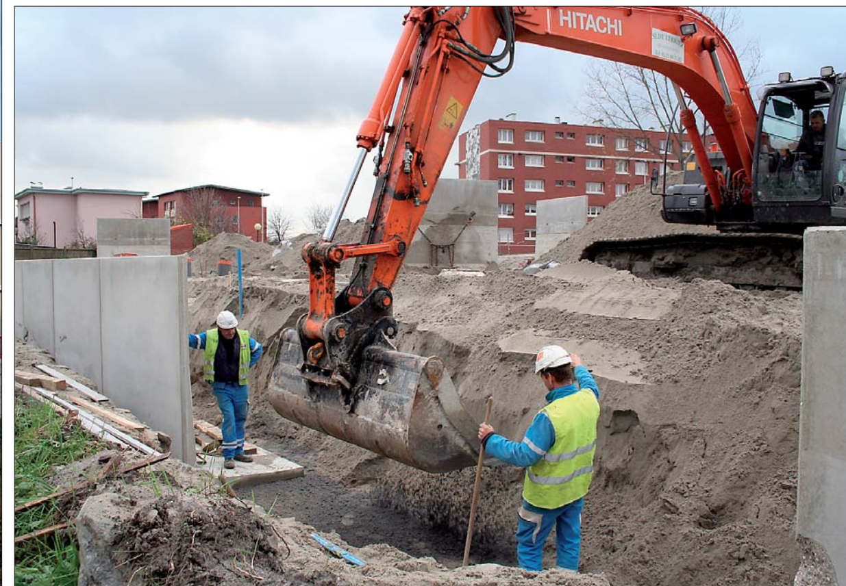
Dernière étape de la rénovation urbaine du Carré de la Vieille, la construction de quatre villas urbaines va débiter.
