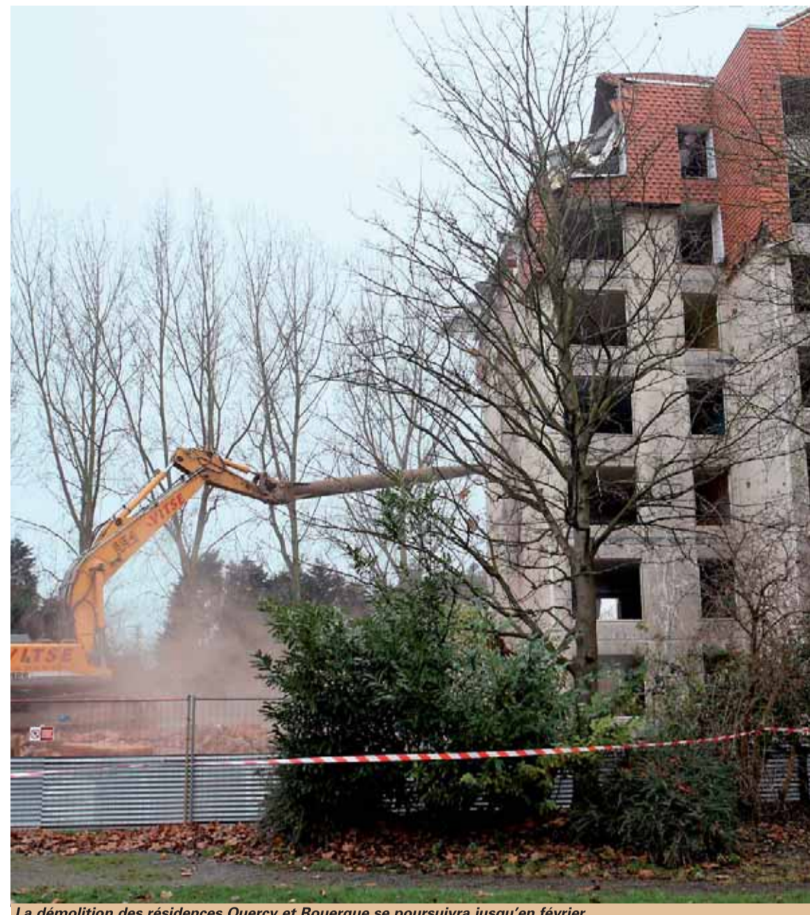
La démolition des résidences Quercy et Rouergue se poursuivra jusqu'en février.
