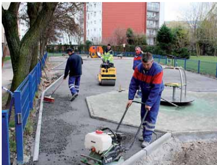
La pose d'enrobé à l'avant et à l'arrière de la maison de quartier a été effectuée mi-mars.
