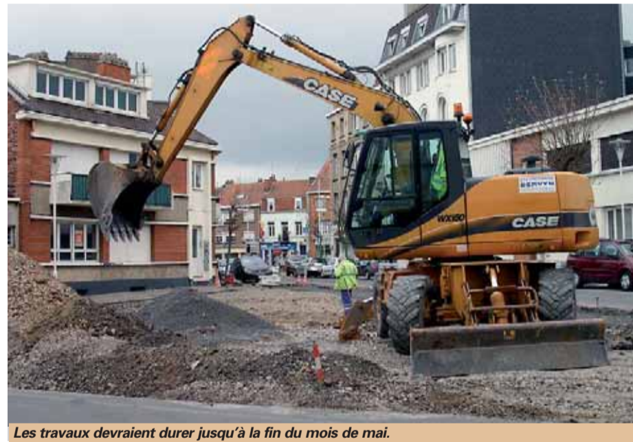
Les travaux devraient durer jusqu'à la fin du mois de mai.
