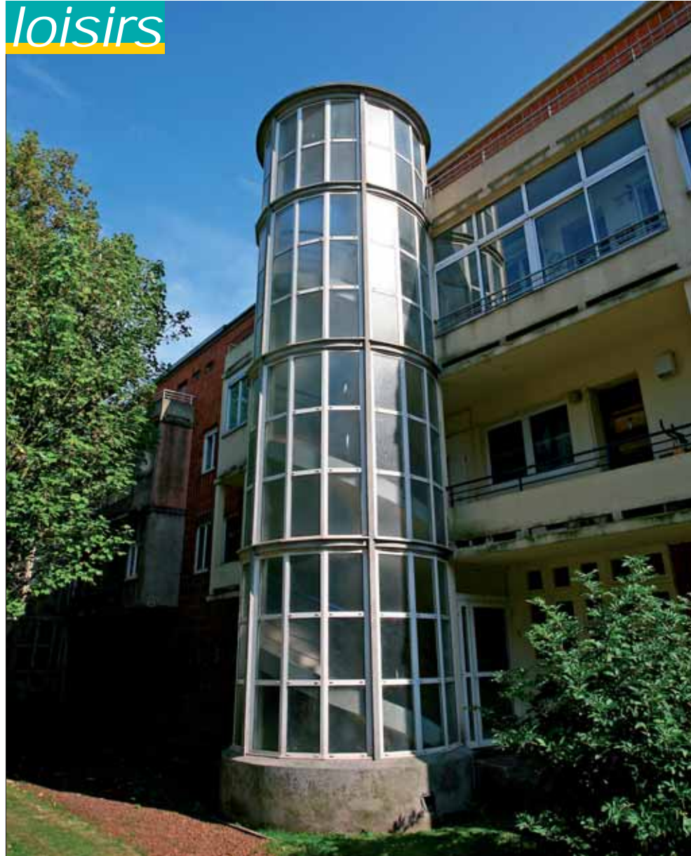
Les escaliers extérieurs des îlots rouges offrent des perspectives et des jeux de forme et de lumière étonnants.
