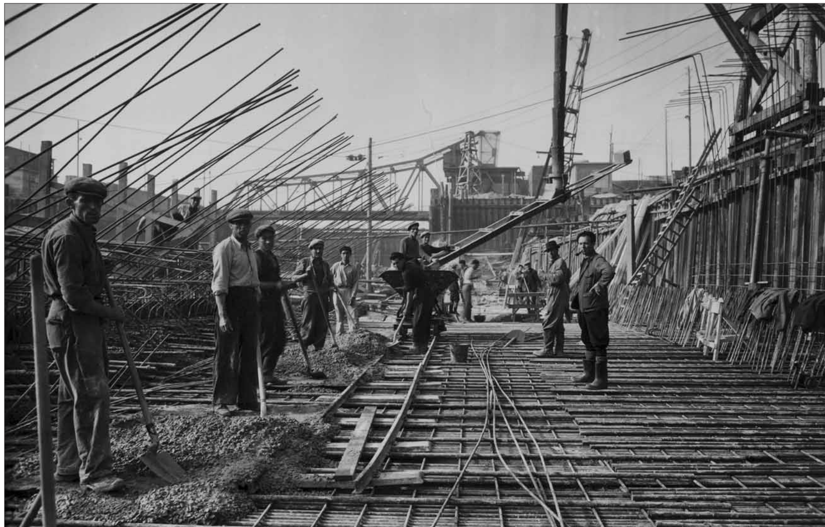
Indispensable au développement économique de la Ville, la reconstruction du port débute avec la remise en état des écluses Guillain, Watier et Trystram.
