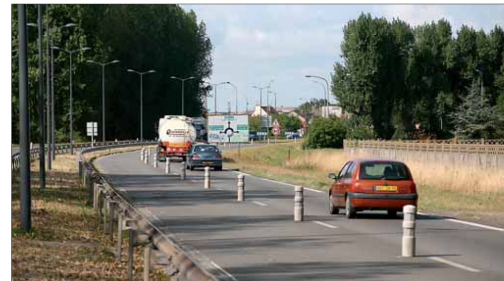
La Ville a installé l'éclairage public en prélude aux travaux de voirie.
