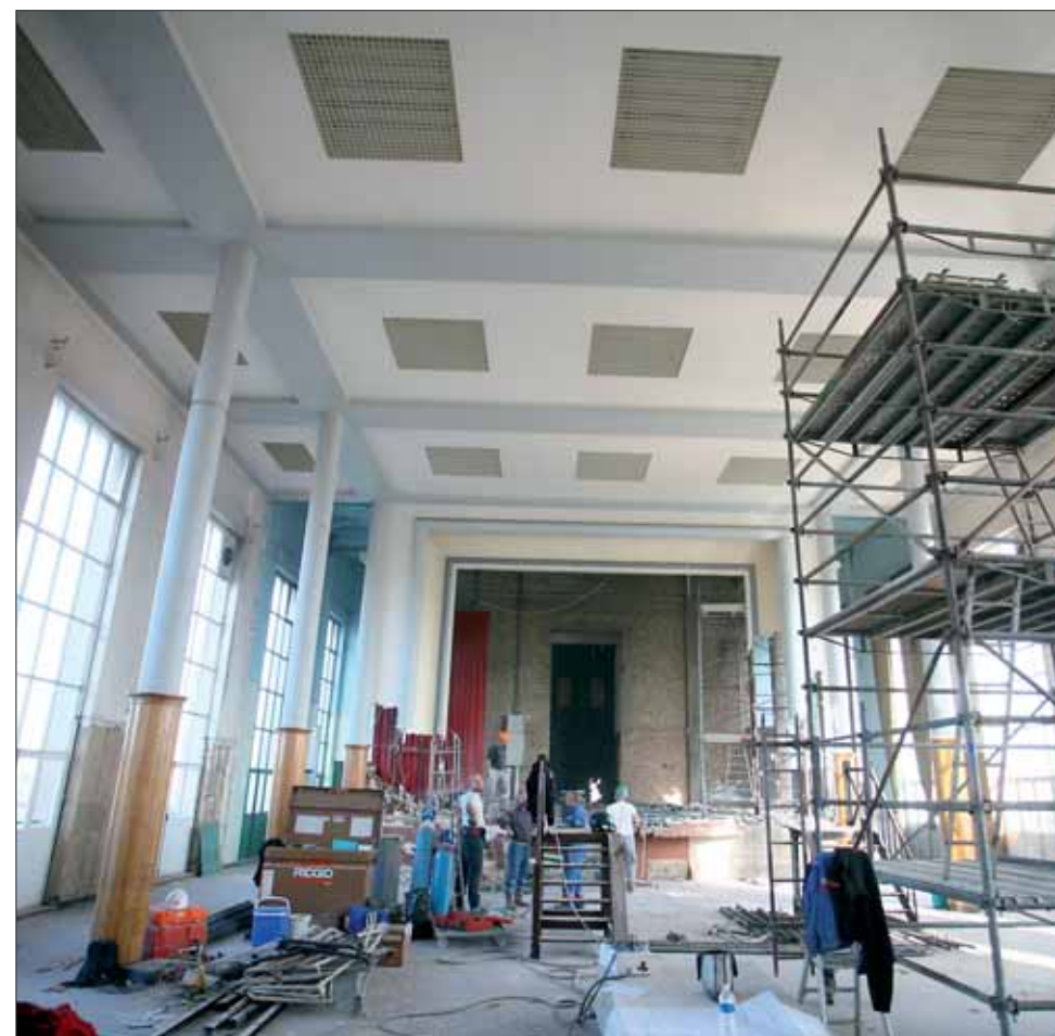
La salle des fêtes de la mairie de Rosendaël est en cours de rénovation.
