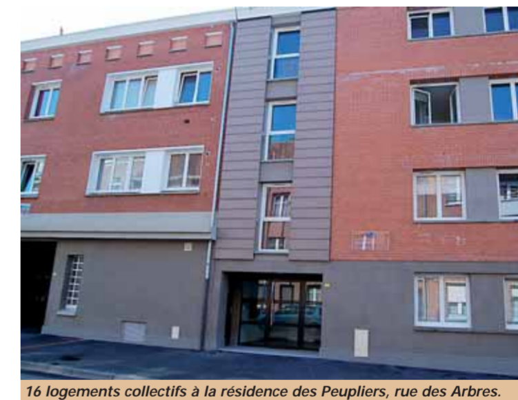
16 logements collectifs à la résidence des Peupliers, rue des Arbres.
