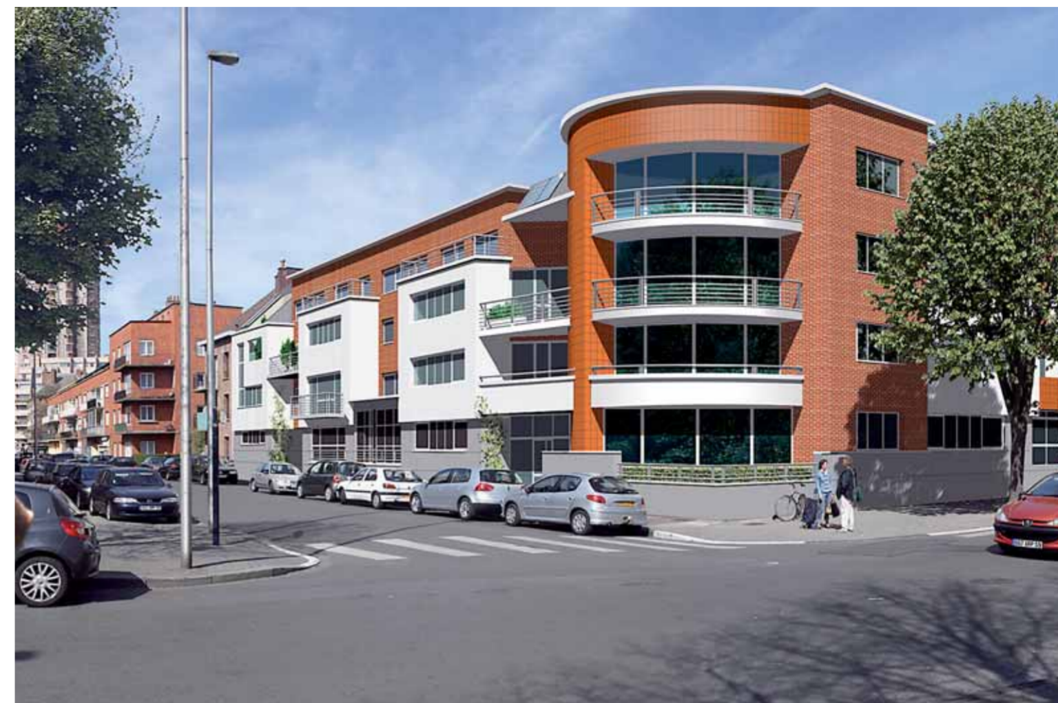
La Maison Flamande vient d'entamer la construction de 17 logements en accession à la propriété sur l'ancien site du Studio 43. © Agence AWA.
