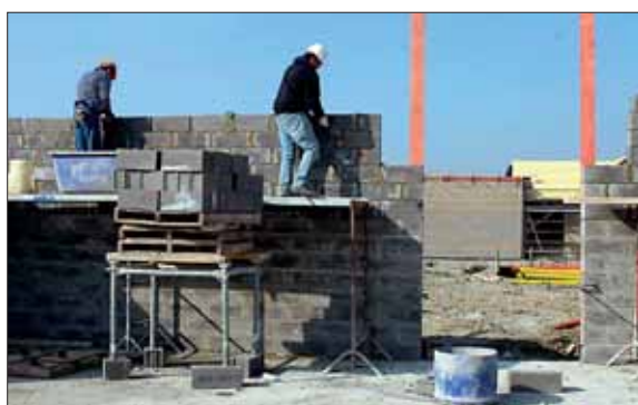
Proposer des formations dans le BTP pour anticiper la construction du terminal méthanier.
