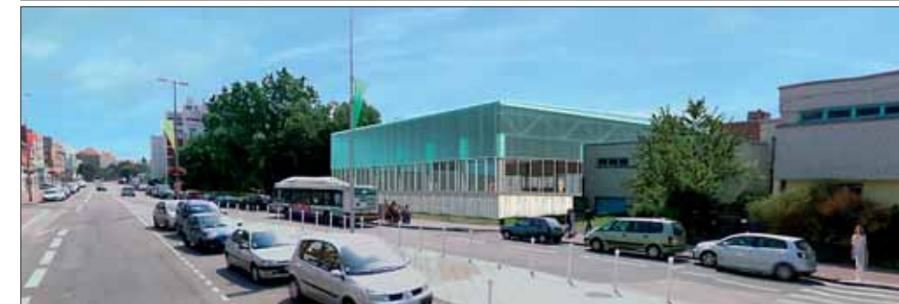
La réhabilitation de la piscine prévoit l'agrandissement du petit bassin et la création d'espaces de remise en forme.
