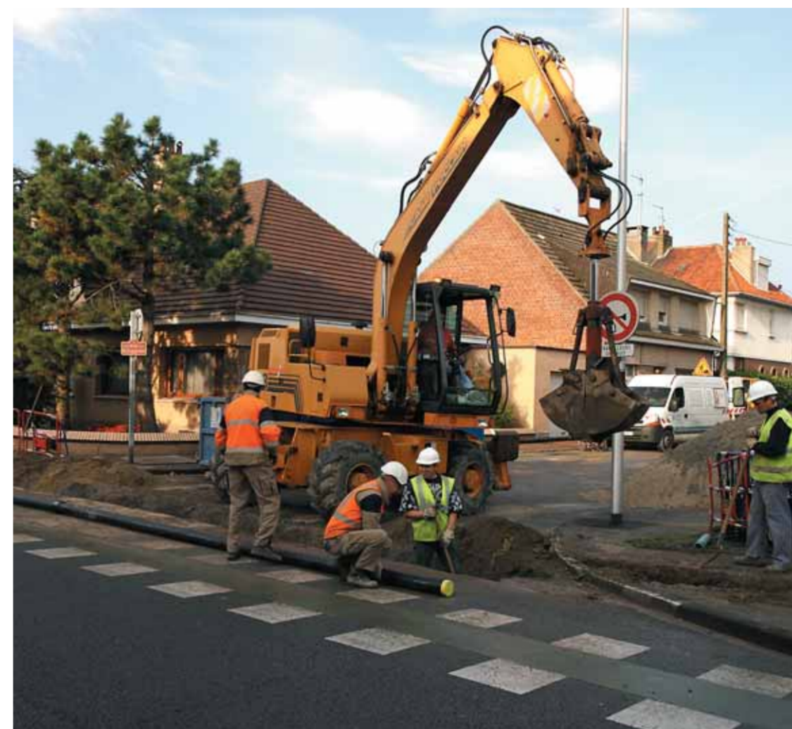
La rue de Normandie est en cours de rénovation.
