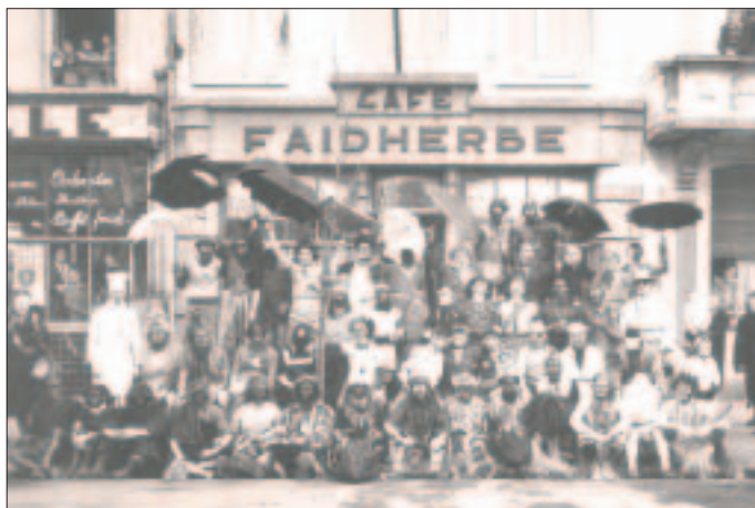
La bande des pêcheurs en 1948, avenue Faidherbe à Malo-les-Bains.
