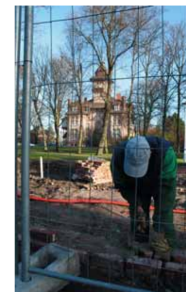
L'ancien mur a été abattu et remplacé par un muret rehaussé d'une grille.
