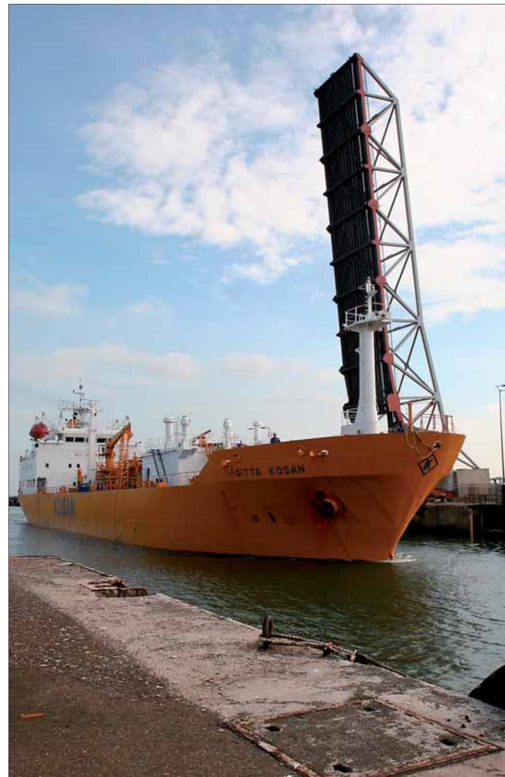
L'écluse Charles de Gaulle est capable de « sasser » des navires atteignant les 125 000 tonnes.
