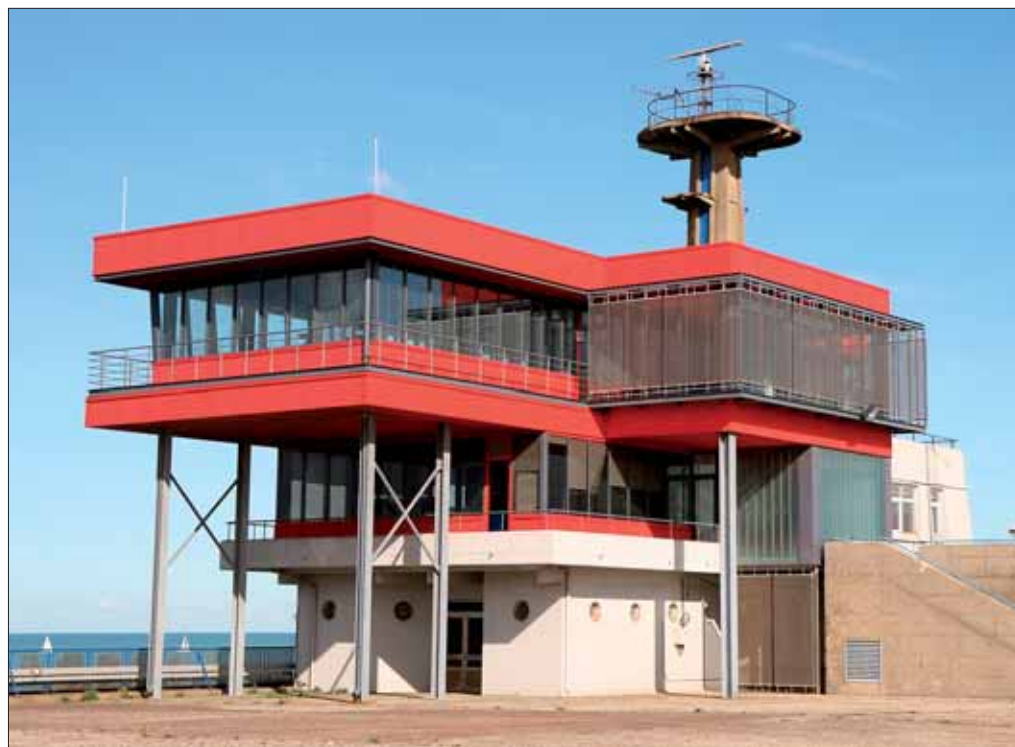
Depuis la tour de contrôle de l'écluse Watier, les opérateurs manœuvrent les ouvrages mobiles des 6 écluses dépendant du Port autonome.
