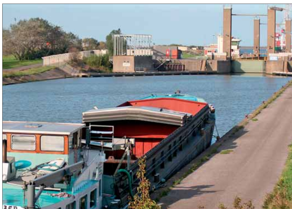
À son lancement en 1969, l'écluse de Mardyck était la seule au monde à disposer d'un système d'échange d'eau douce et d'eau salée.
