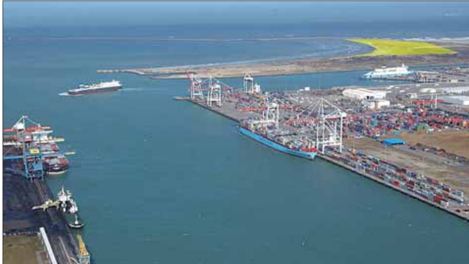
Le terminal méthanier sera implanté dans la zone du Clipon (en jaune sur la photo).
