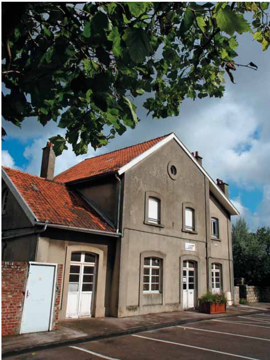
Le projet retenu par les habitants et les élus prévoit la sauvegarde de la gare de Leffrinckoucke.
