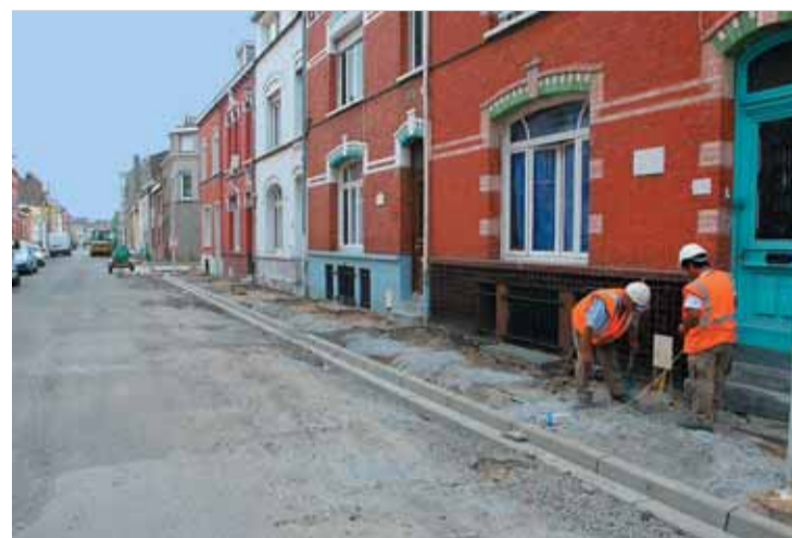
Des briques jaunes et rouges orneront bientôt les trottoirs de la rue Belle Rade.
