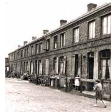
Exemple typique de l'habitat ouvrier datant du XIX e siècle.
