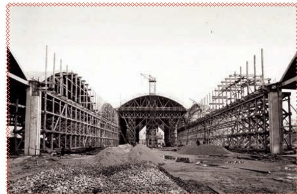
Sur le môle 3, le hangar aux textiles « Léon-Herbart » est reconstruit en 1951 sur 50 000 m<sup>2</sup> couverts grâce à un ingénieux système de voûtes paraboliques en béton. En novembre 1951, le môle 4 est pourvu du tout nouveau hangar aux primeurs « Émile-Dubuisson ».
