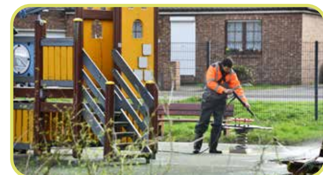
↑ Travaux en cours dans le Square des Enfants.
