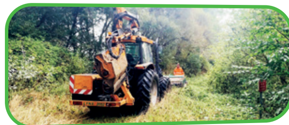
Les travaux de création d'un cheminement dans les Salines ont déjà démarré
