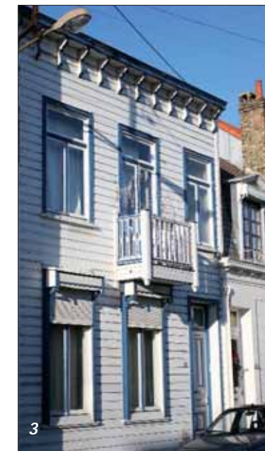
3- Une des dernières maisons de bois de la rue Carnot.
