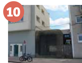
10 126 digue de Mer à Malo-les-Bains
