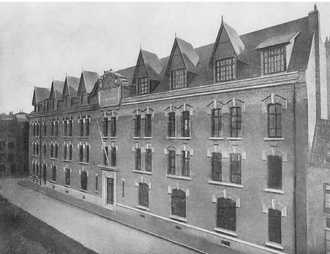
Façade principale du collège vers 1920
